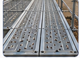
Platformlar boşluksuz, kilitleri kapalı ve sağlam olmalı.
