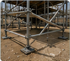
Zemin düzgün ve ayaklar düzgün yerleştirilmiş.
